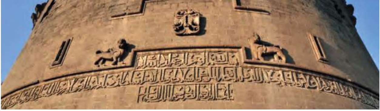
Görsel 3.83: Diyarbakır Surları, Yedi Kardeş Burcu
